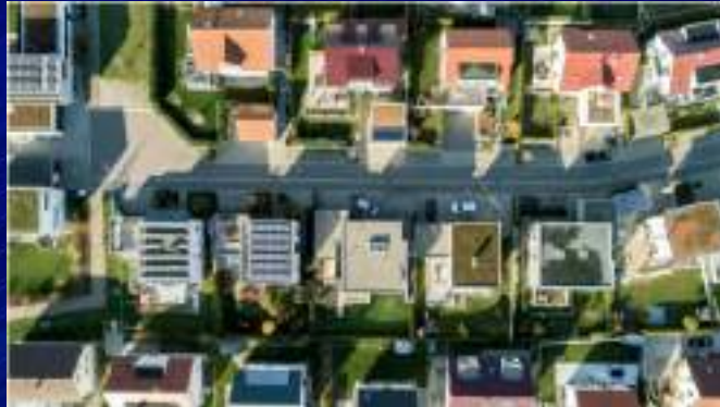
インテリジェントなビルヒーティング管理(フィンランド、スウェーデン)
